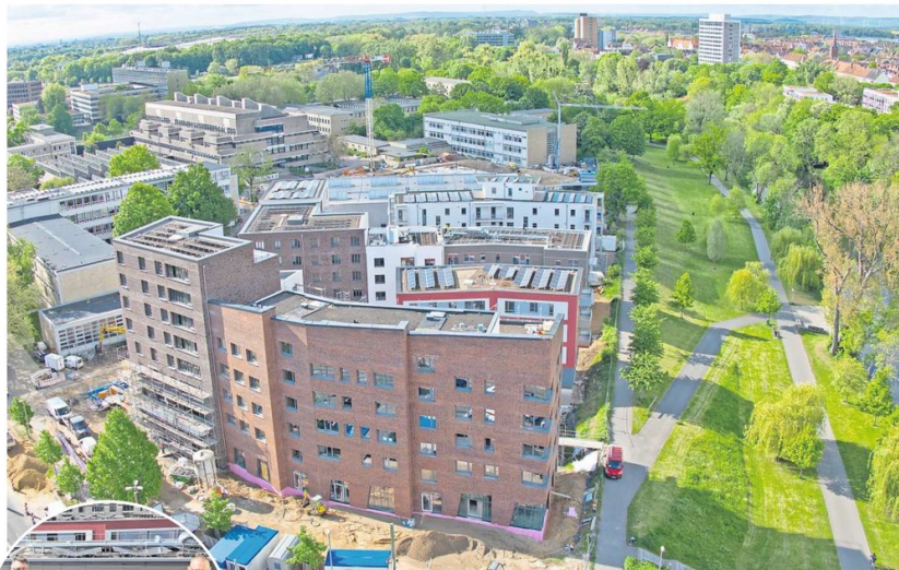
Die Ohe-Höfe kurz vor Fertigstellung, fotografiert vom gegenüberliegenden Hochhaus.
